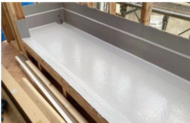
FRP防水のトップコートを塗布した状態
